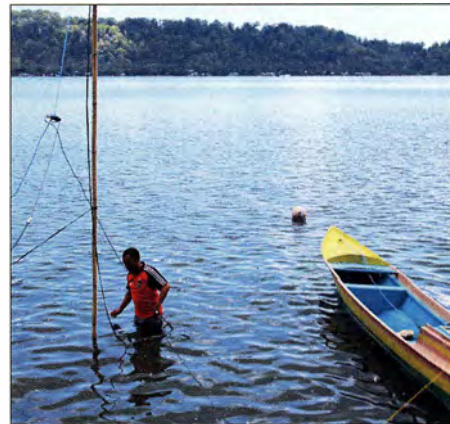
Agus, YC8VRA, bei letzten Antennenarbeiten während bereits auflaufendem Wasser
